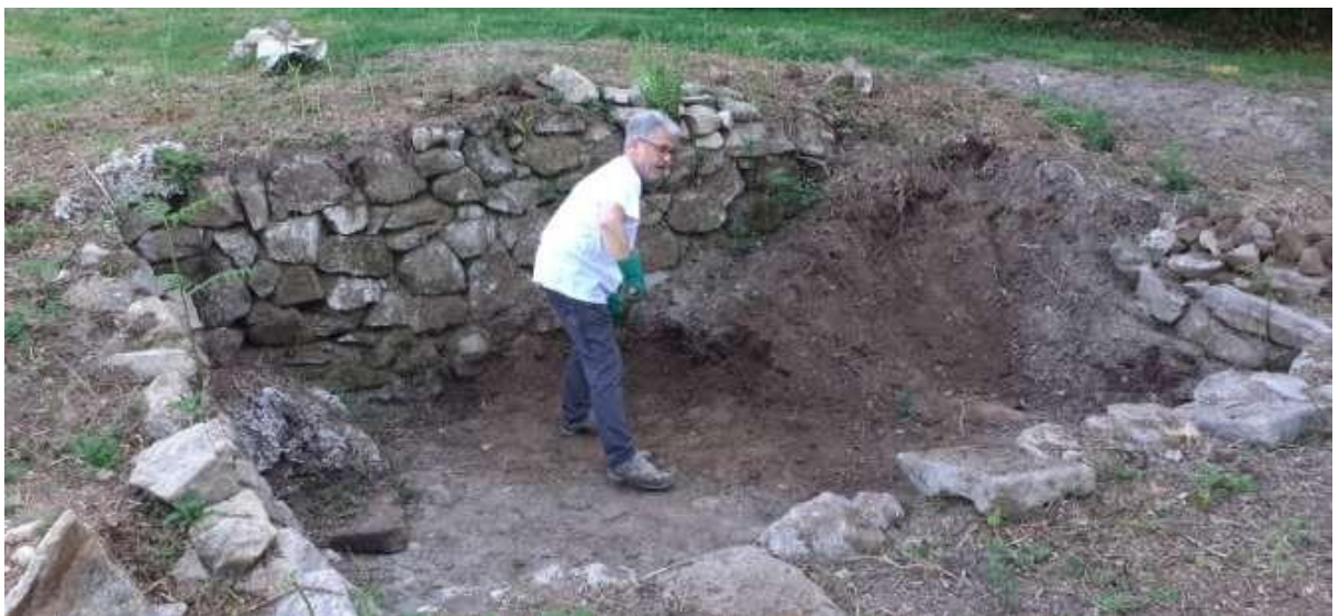
Avant notre arrivée, Jean-François avait commencé l'évacuation de la terre.
