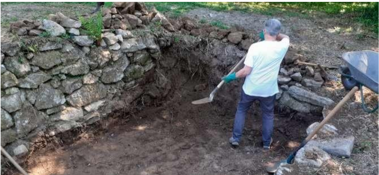
Petit à petit, le tas de terre s'amenuise.
