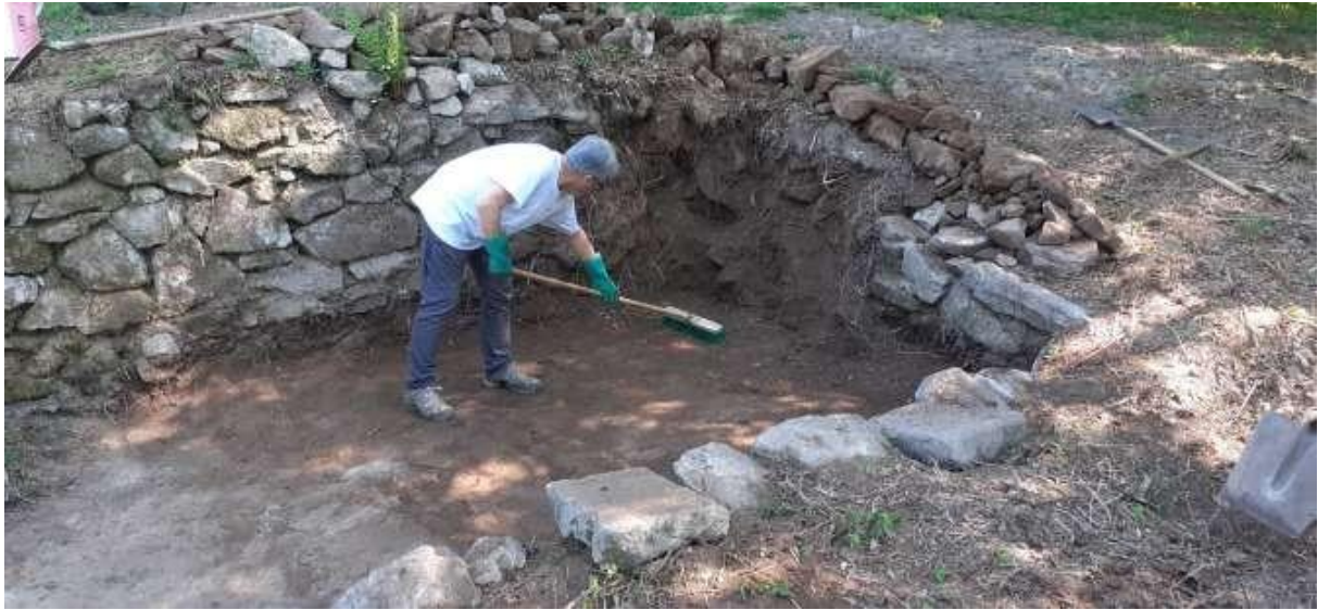
Le tas de terre étant évacué, Jean-François nettoie le fond du lavoir.
