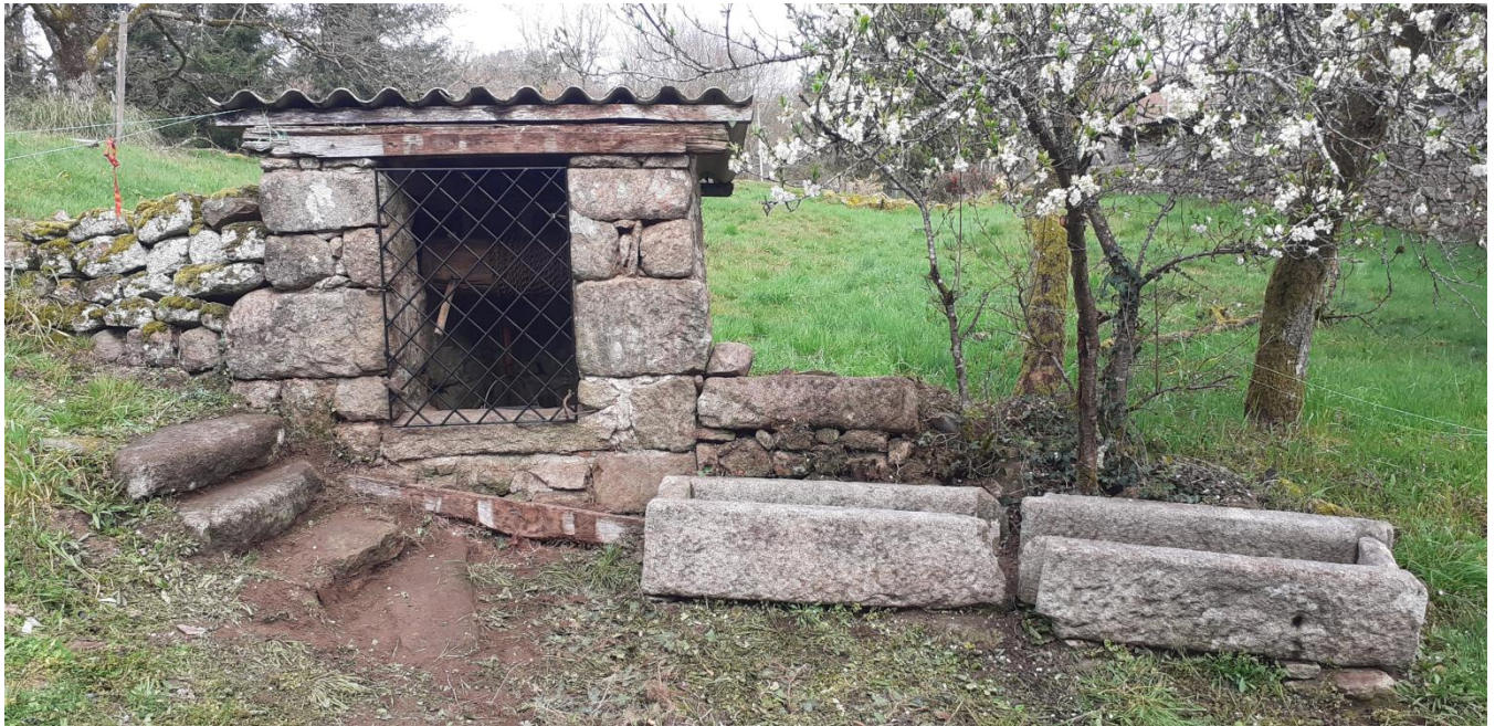
Ajout d'une grille de protection.
