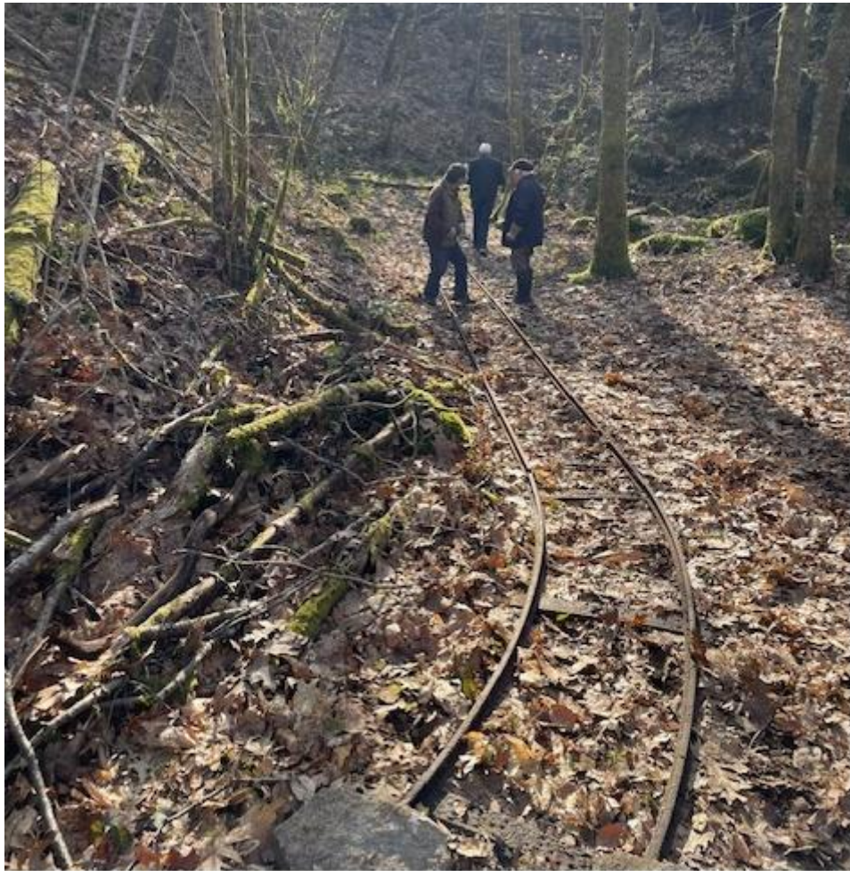
Installation en cours par Christian, Jean-Pierre et Claude.
