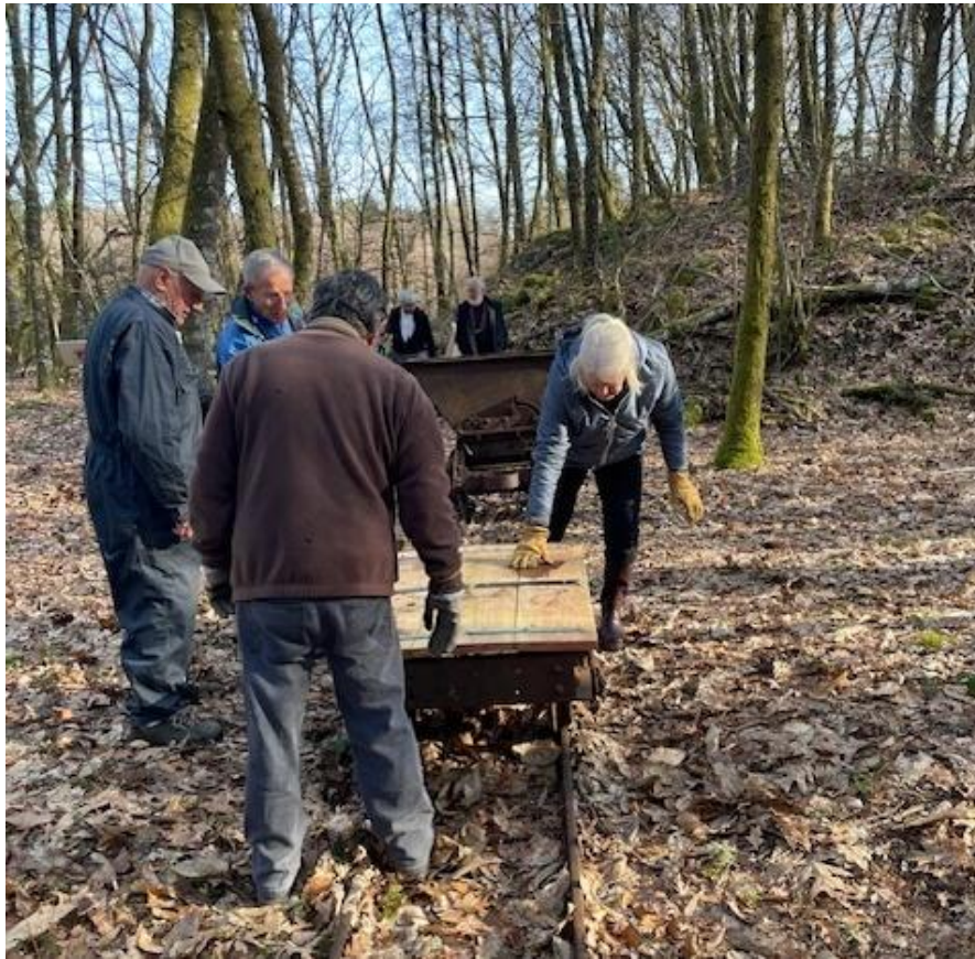
Préparation de la mise en place du bloc.
