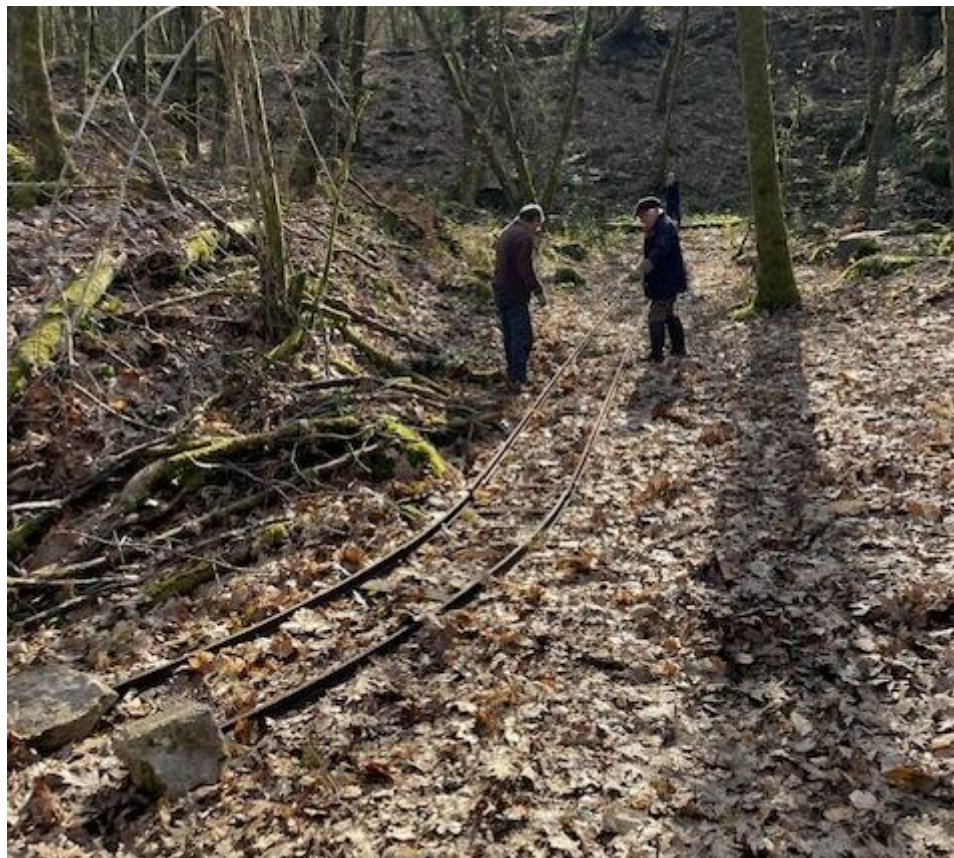
Rails installés, Christian et Claude contrôlent le bon raccordement des rails.
