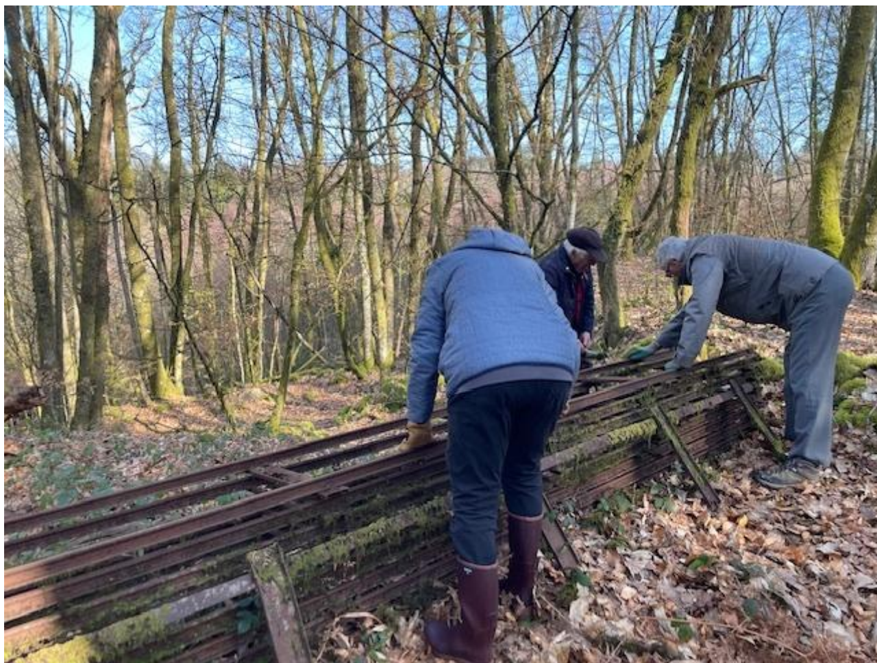
Nettoyage des rails avant leur installation par Françoise, Claude et Gilles.
