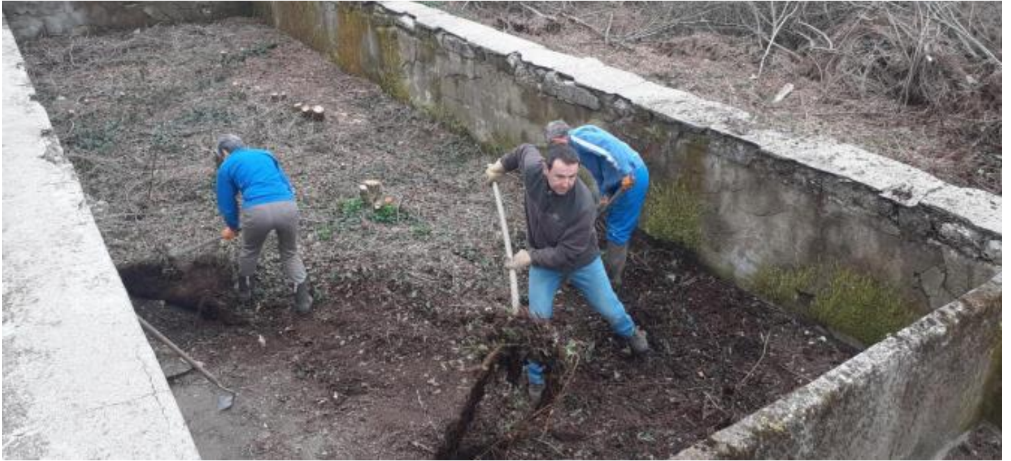
Françoise, Fabrice et Gérard s'activent dans la partie réserve d'eau.
