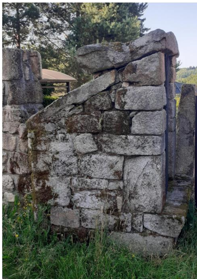
Côté du puits
