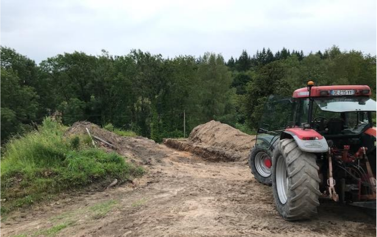
Création d'une tranchée à l'entrée du jardin.
