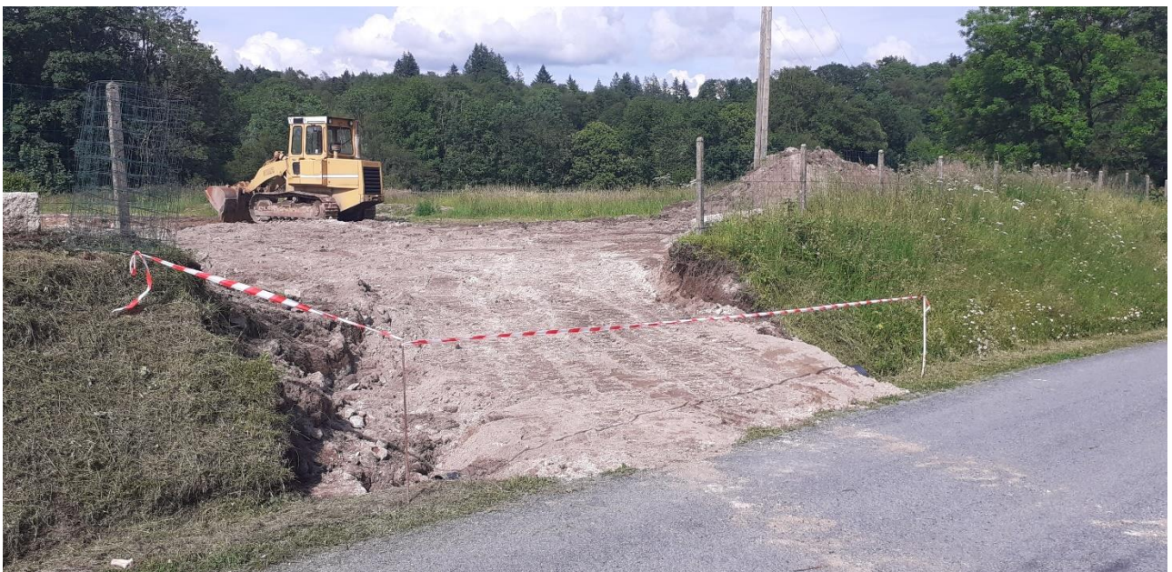
Passage établi pour le transfert de terre d'un côté à l'autre du site. Le fossé a été busé.
