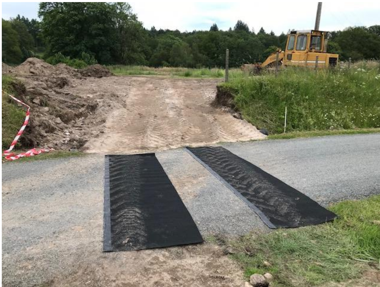
Mise en place de bande de caoutchouc afin de protéger la chaussée.
