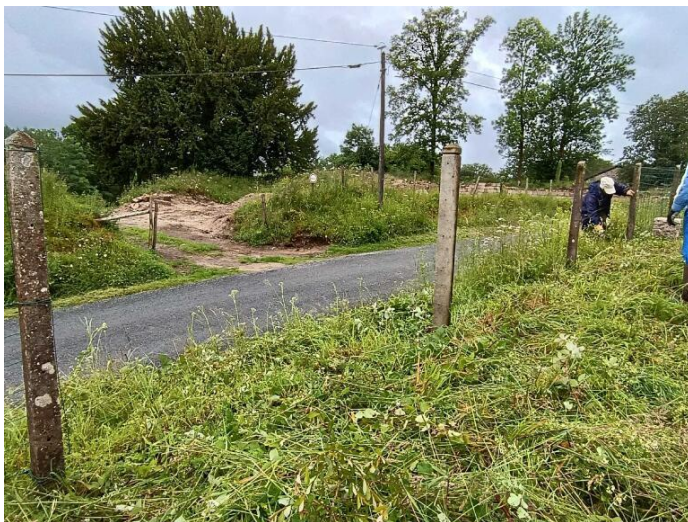
Nettoyage des abords avant la création du second accès.
