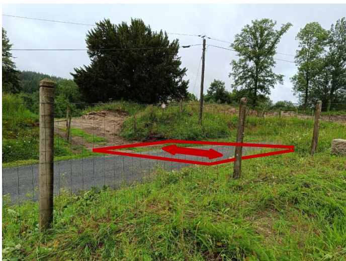
Repose de la clôture, rendue amovible. Passage pour le transfert de terre d'un côté à l'autre du site.
