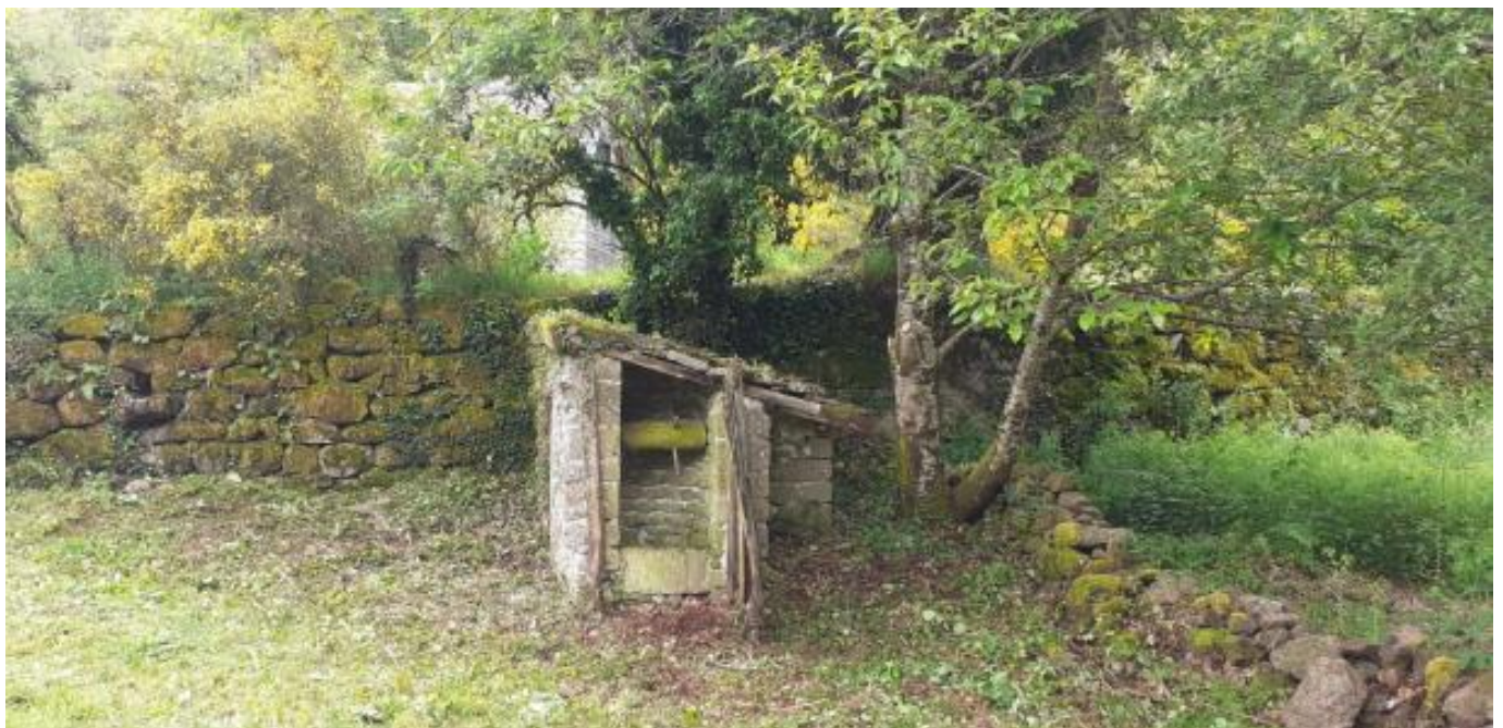
Chantier terminé (élément 1028).
