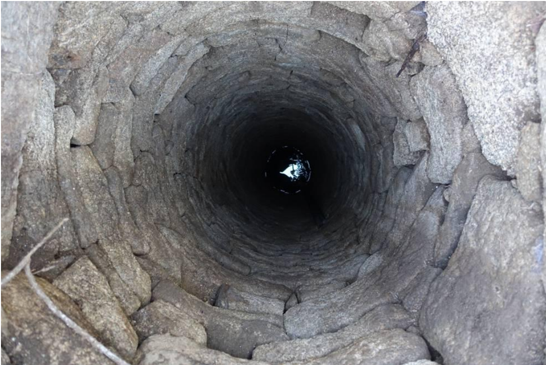
L'intérieur du puits, l'eau est à 7,50 m
