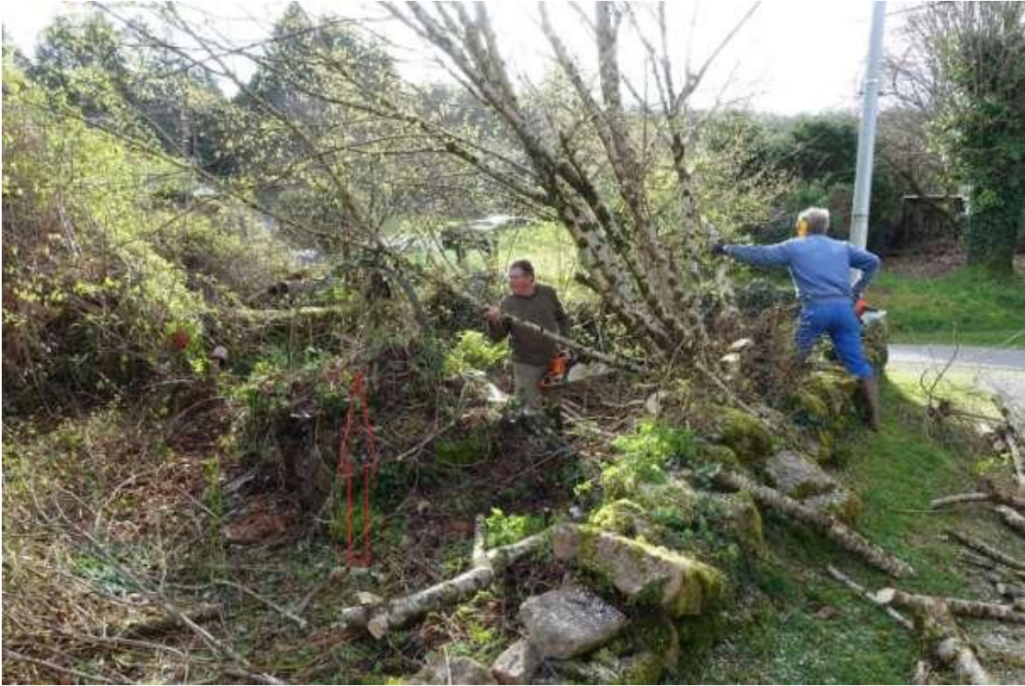
Grâce à Christian et Gérard, on commence à apercevoir le puits.
