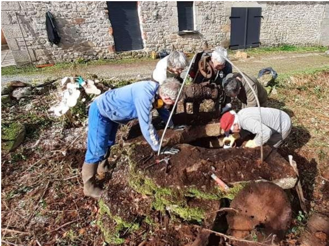
L'entrée du puits est dégagée. Présence d'eau ? → Oui !
