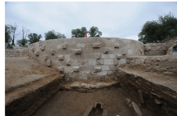
Fig. 31. Coup de sabre dans la maçonnerie du chevet (état II, sondage de 2016)
