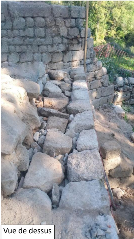
Vue de dessus - Calage des blocs
