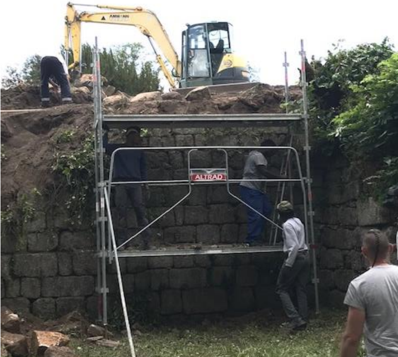
Préparation du chantier de reconstruction : échafaudage pré-ventif par l'entreprise « Les chantiers des chemins jacquaires »
