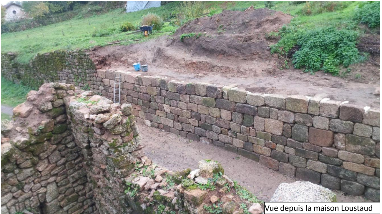
Finition du dessus du mur
