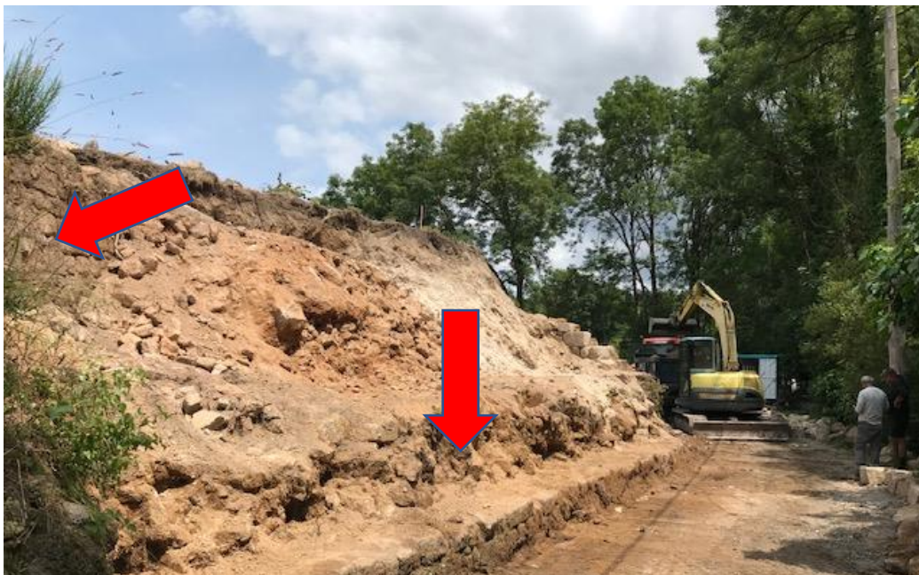
Nettoyage et décapage du talus côté rue de la porte de la voûte, découverte d'un mur en arrière, prolongement de celui mis au jour côté route des Barrys et de soubassements de l'ancien mur
