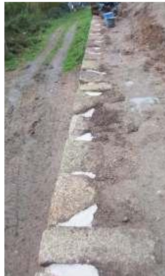
Finition du dessus du mur
