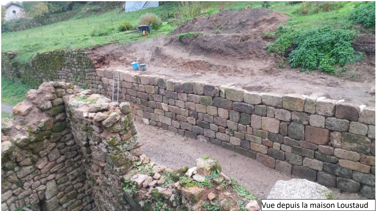
Finition du dessus du mur
