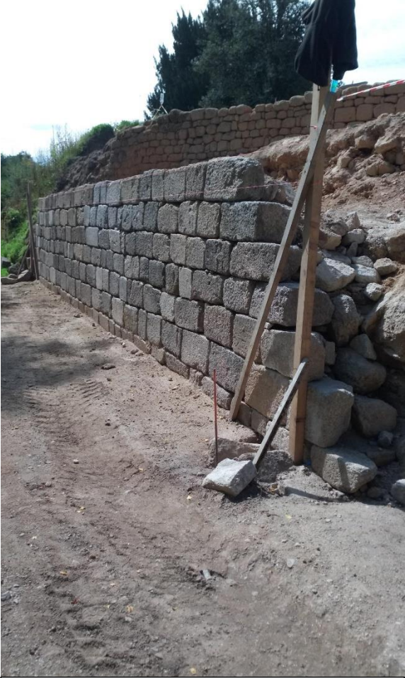
Vue depuis la route des Barrys
