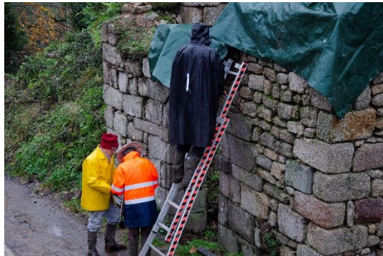
Mise en place de la bâche
