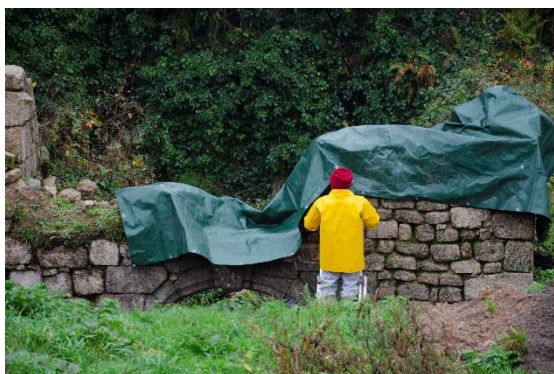
Mise en place de la bâche
